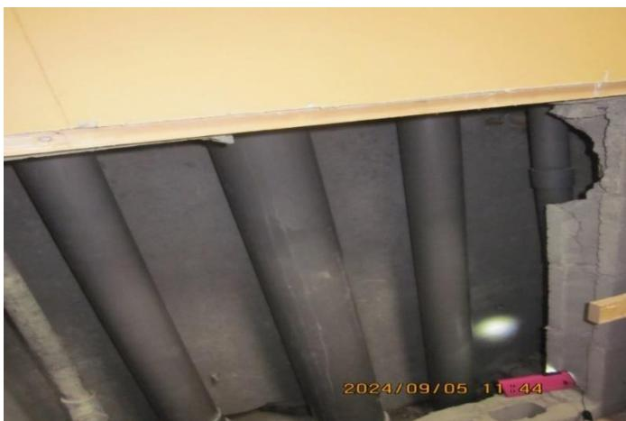
管は5本あった。左側の細い管は都市ガス管（電化にしたので使用していない）。隣は破損していた雑排水管。真ん中の太い管は汚水管。右から2本目は通気管。右端に一部見えているのは、温水器の蒸気排水管。
