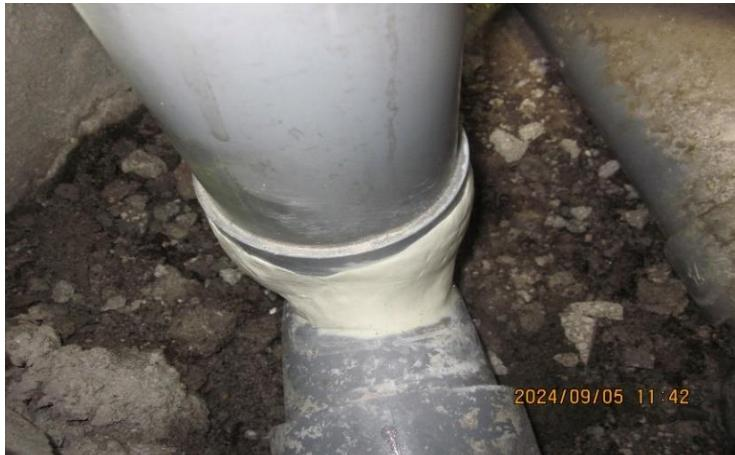
接着剤で亀裂を塞ぐ応急措置をした。トイレの床も剥がし、階下のブロックを取り除き、塩ビ管を取替える本格的復旧は、雪が降って作業員確保ができてから行う。→理事会では本格的復旧は行わず、このままで塞ぐことにしました。
