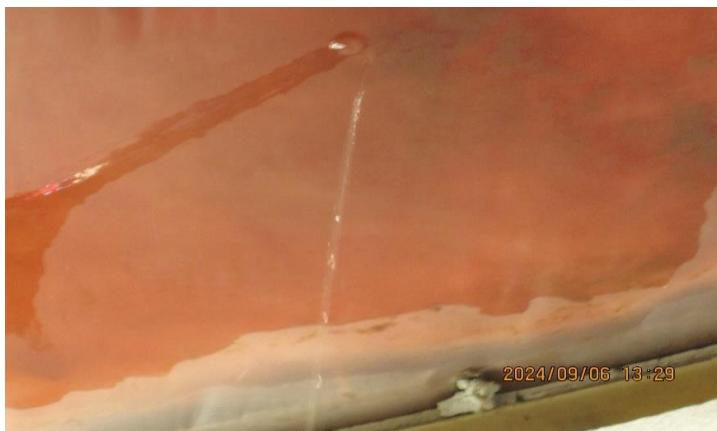
階下の部屋の天井。天井板が漏れた水で落ちてしまい、天井裏の断熱材が見えた状態。断熱材を包むビニールに水がたまっておりそれが水漏れしていたので、そのビニールに針で穴を開け、水を逃した。
