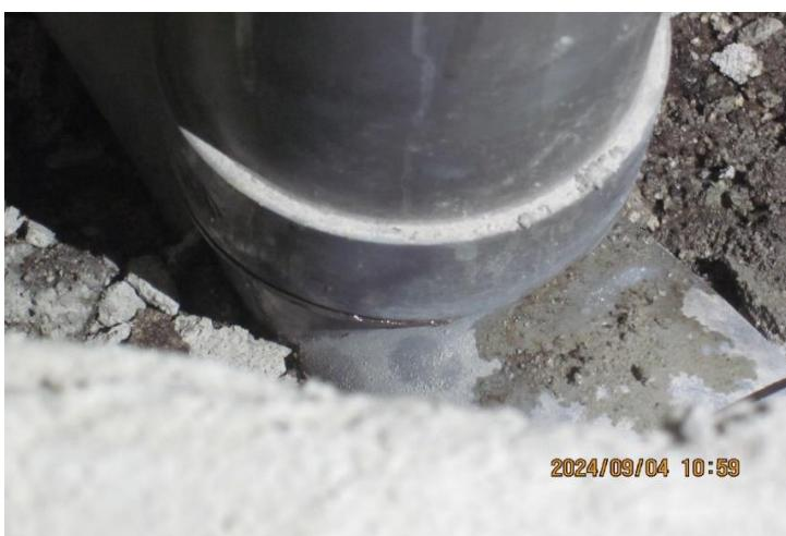
前ページの写真の雑排水管の最下部に小さな点のように白く光って見えるのは、上階から流れてきて漏れている雑排水。
